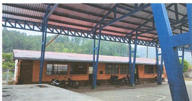
Foto 3: Mejoramiento de techado
