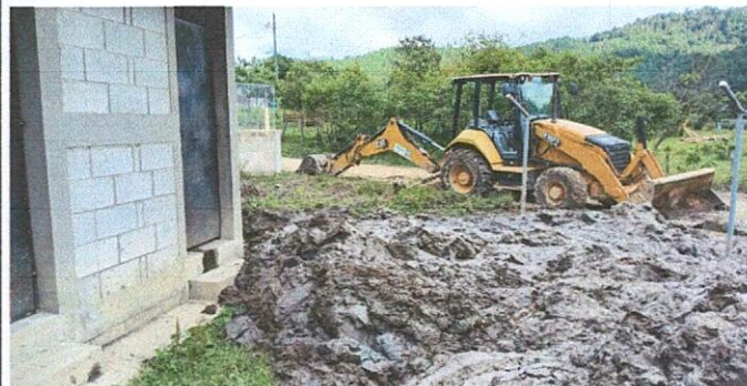
Foto 2: Mejoramiento de fosa septica
