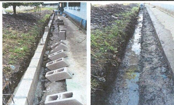
Foto 4: Mejoramiento de cuneta y muro de contención
